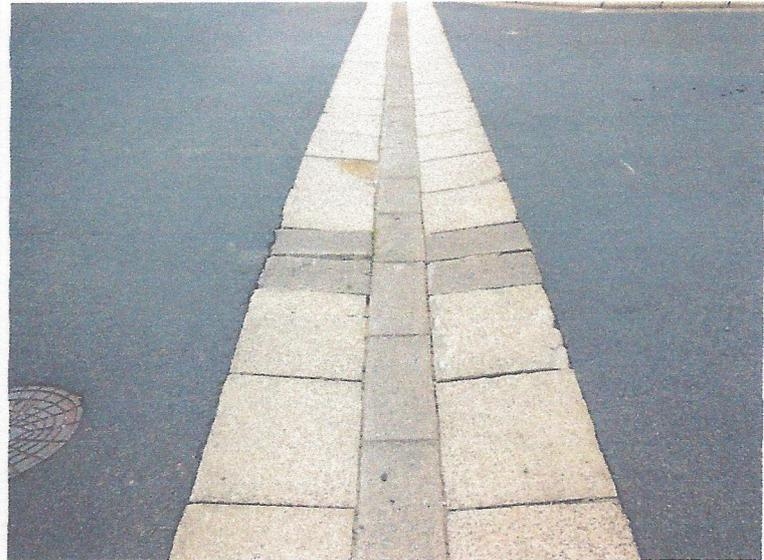
Offene Fugen entlang der Betonabdeckung der Bachmauer „Am Grundrain“ → Frostschäden zu erwarten
